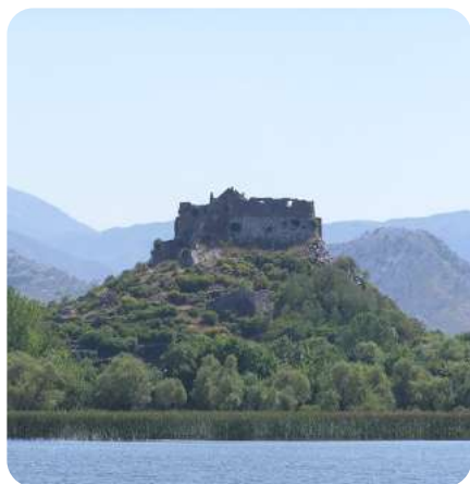
Tepesindeki Žabljak Crnojevića Kalesi
