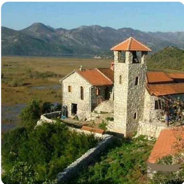
อารามคอมจากด้านบน
