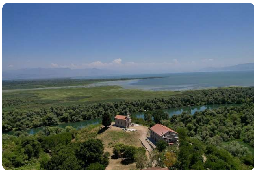
上から見たVranjina修道院
